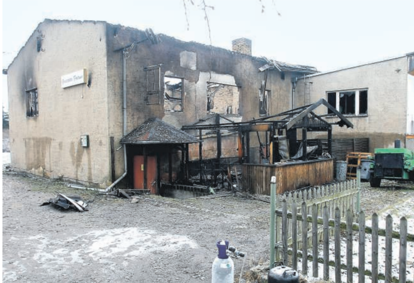
Die Gaststätte Fortuna in der Theklaer Seelestraße gestern Früh: Ein Brand hat das beliebte Lokal nahezu vollständig zerstört. Das Gebäude muss wahrscheinlich abgerissen werden. Foto: André Kempner
