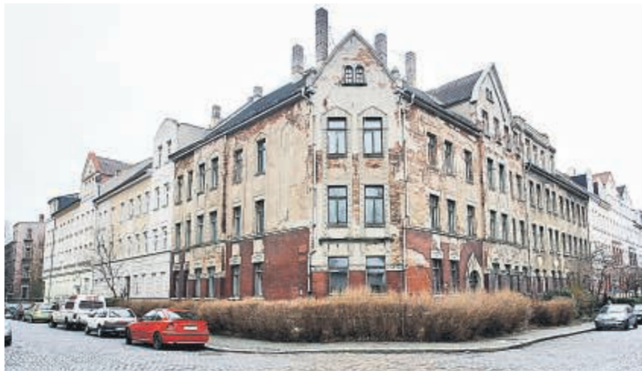
Problem-Quartier – das Bülow-Viertel soll durch ein Pilotprojekt aufgewertet werden. Foto: André Kempner
